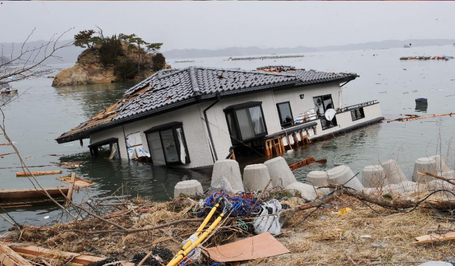
Nach der Flut: scheinbare Normalität – und totale Zerstörung.
